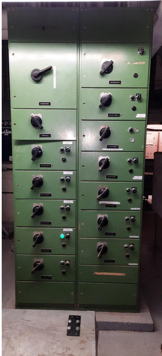
Centre de démarreurs CD3 Cabanon C (avant et arrière)
