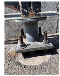
Plaque d'ancrage actuellement en place
