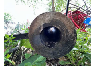
Base de la nouvelle barrière en aluminium
