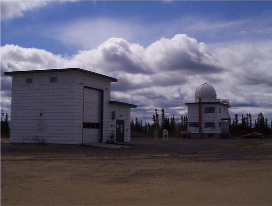
La station aérologique - bâtiment des opérations (à droite) et le hangar à hydrogène (à gauche) où ont lieu les lancements de ballons.
