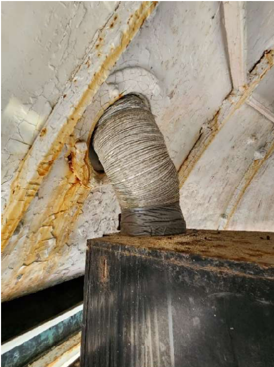
Figure 4 : Collet du côté intérieur
