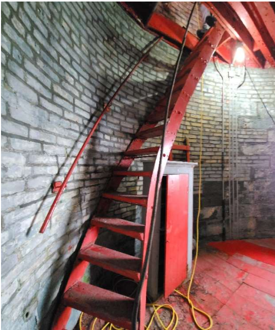
Figure 31 : Escalier entre le 7 e et le 8 e étage
