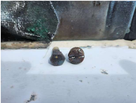
Figure 10 : Têtes des boulons des parcloses
