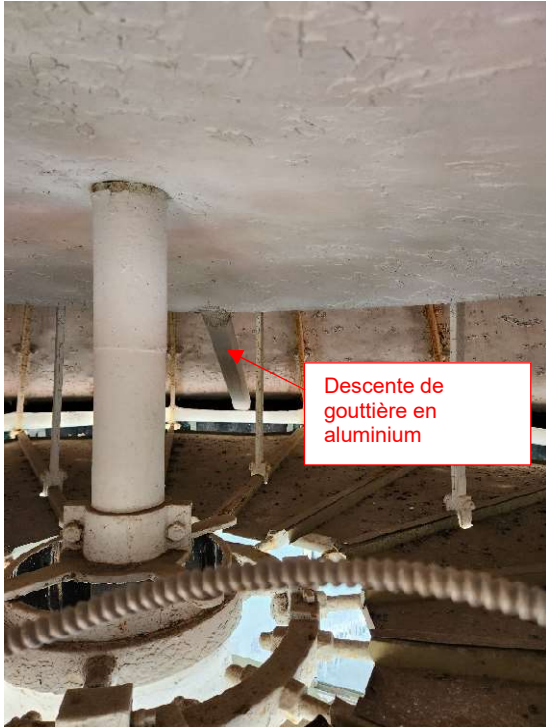
Figure 16 : Localisation du conduit de descente de gouttière à remplacer.
