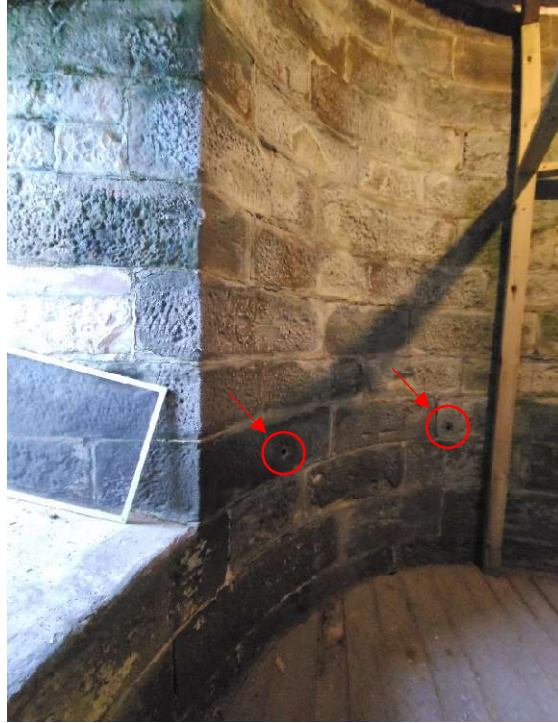
Figure 30 : Localisation des trous de ventilation à obturer.
