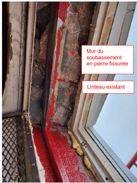
Figure 19 : Linteau de la porte d'accès à la galerie
