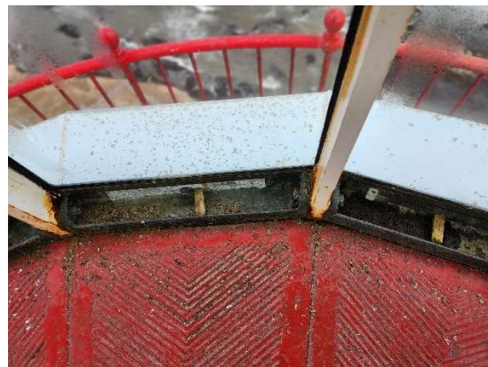
Figure 15 : Trappe et charnière en aluminium
