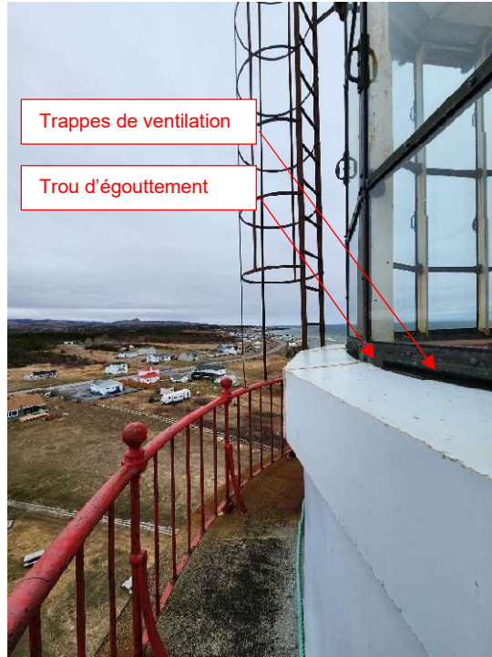
Figure 9 : Jonction lanterne – soubassement - galerie
