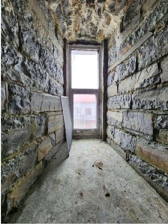
Figure 29 : Fenêtre type de la tour.
