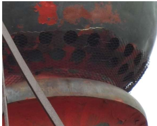
Figure 7 : Grillage existant retenu par du fil de fer.
