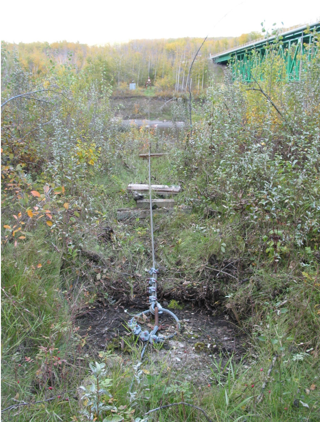
Figure 4: Infrastructure sur la rive gauche (Remarque : le câble central principal a été retiré)
