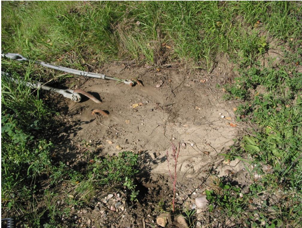
Figure 2: Ancrage en béton côté maison rive droite
