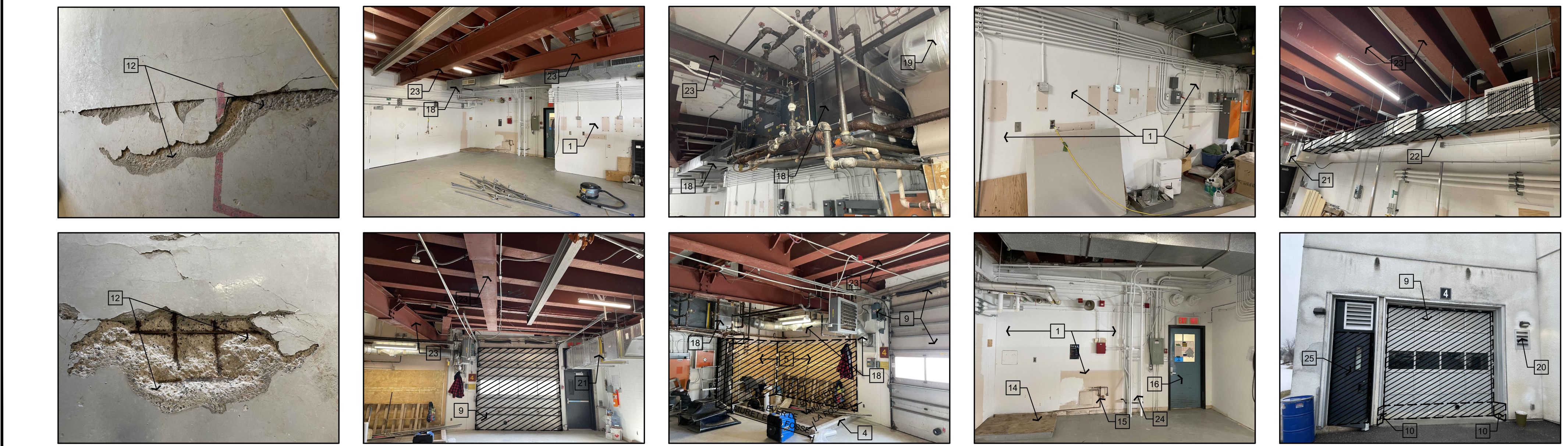
3 PHOTOS DE RÉFÉRENCE - CONDITIONS EXISTANTES ÉCHELLE = 1:50
