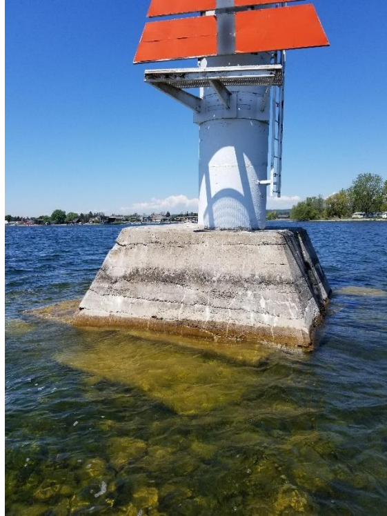
Figure 4 : Phare d'alignement antérieur LL487 de Brighton existant – Vue vers l'ouest, au niveau de l'eau
