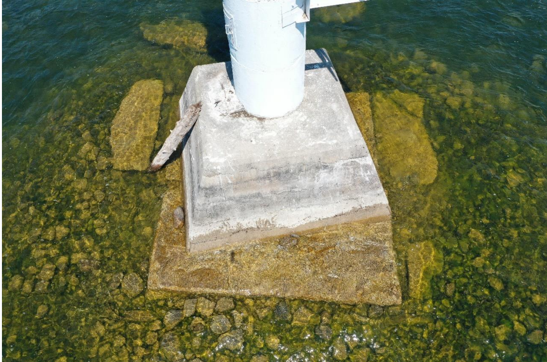
Figure 8 : Phare d'alignement antérieur LL487 de Brighton existant – Vue vers le nord
