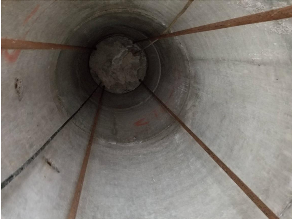
Figure 11 : Phare d'alignement antérieur LL487 de Brighton existant – Intérieur
