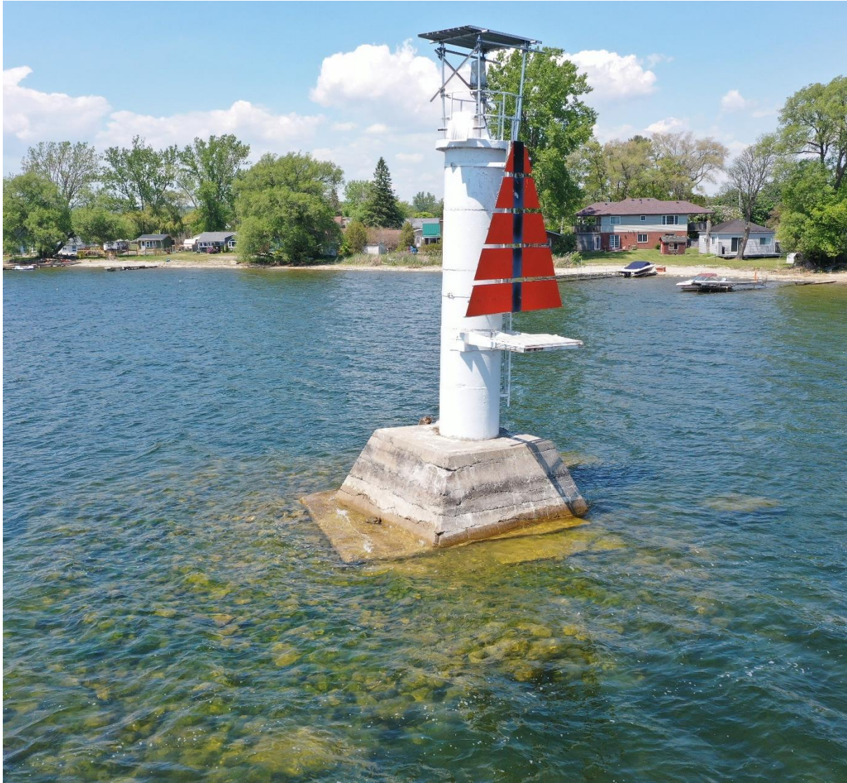
Figure 3 : Phare d'alignement antérieur LL487 de Brighton existant
