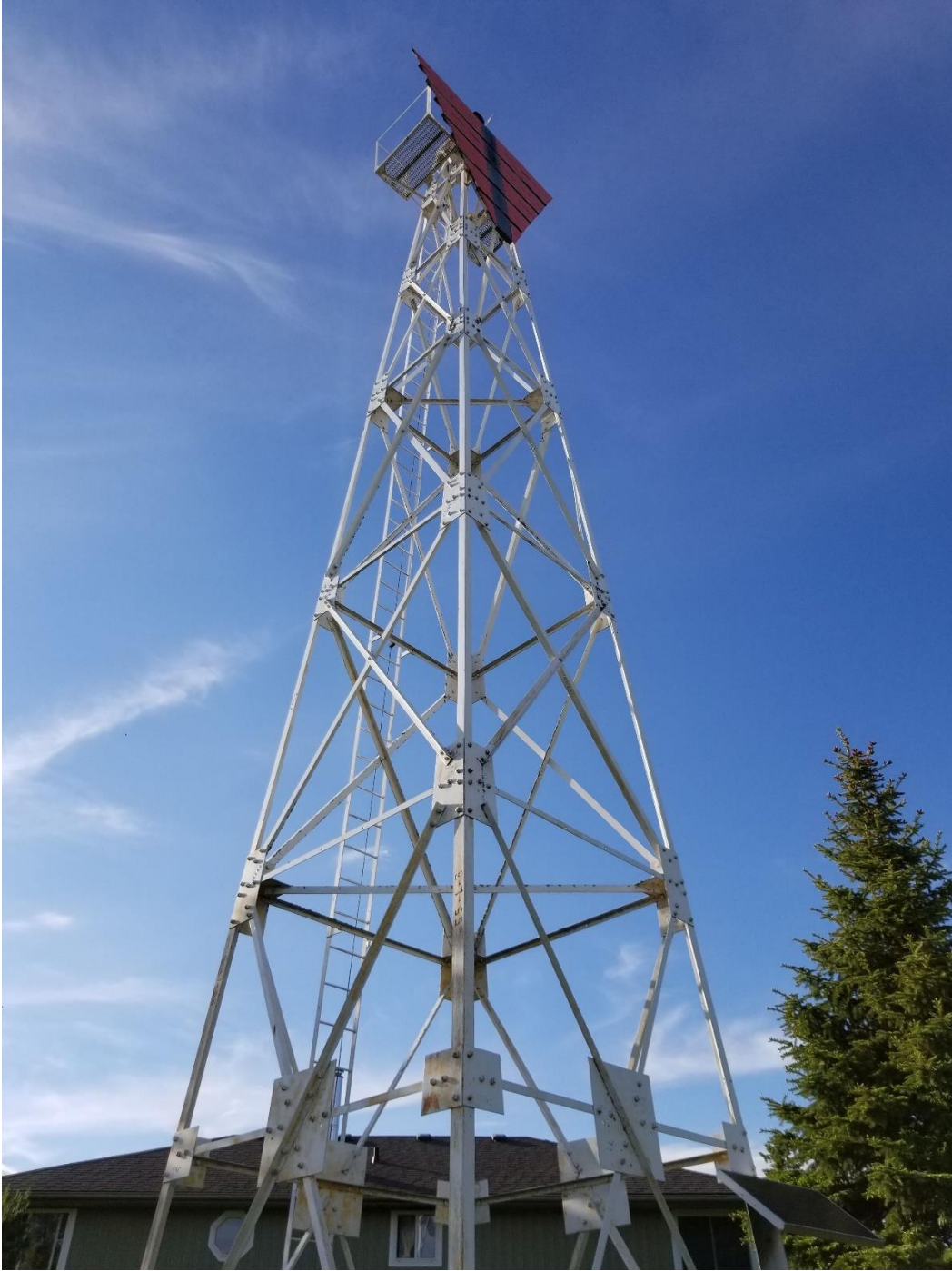
Figure 13 : Phare d'alignement postérieur LL488 de Brighton existant – Vue en contreplongée
