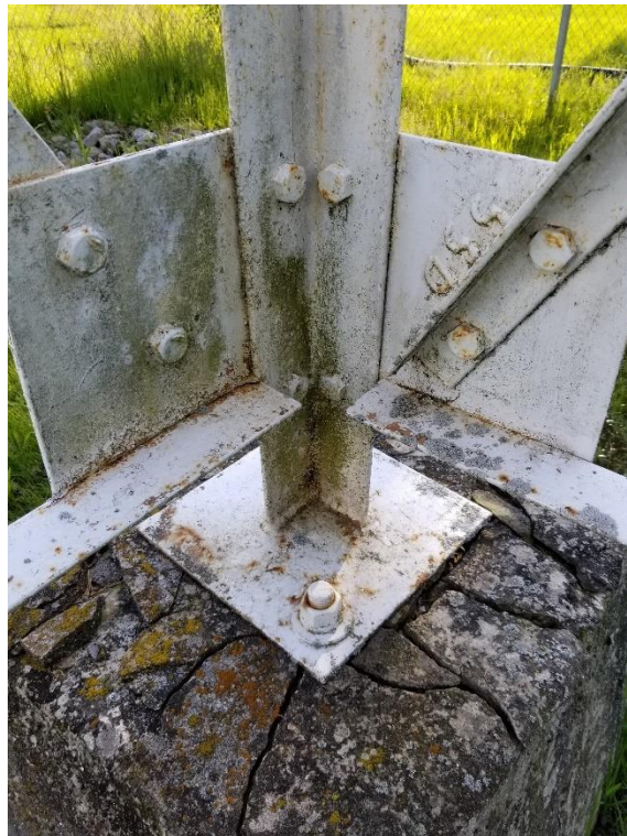
Figure 16 : Phare d'alignement postérieur LL488 de Brighton existant – Semelle de béton
