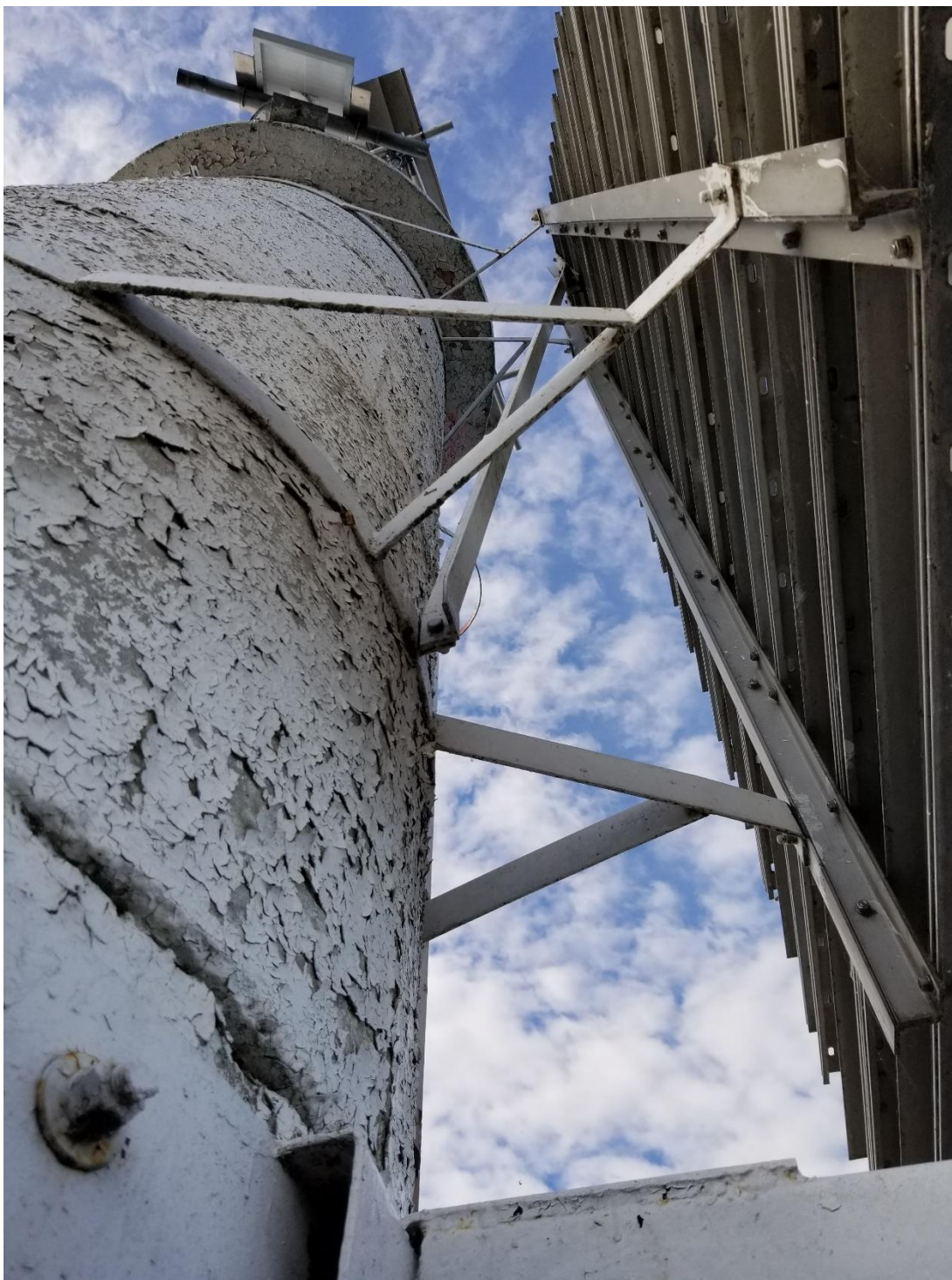
Figure 10 : Phare d'alignement antérieur LL487 de Brighton existant – Panneaux de marques de jour
