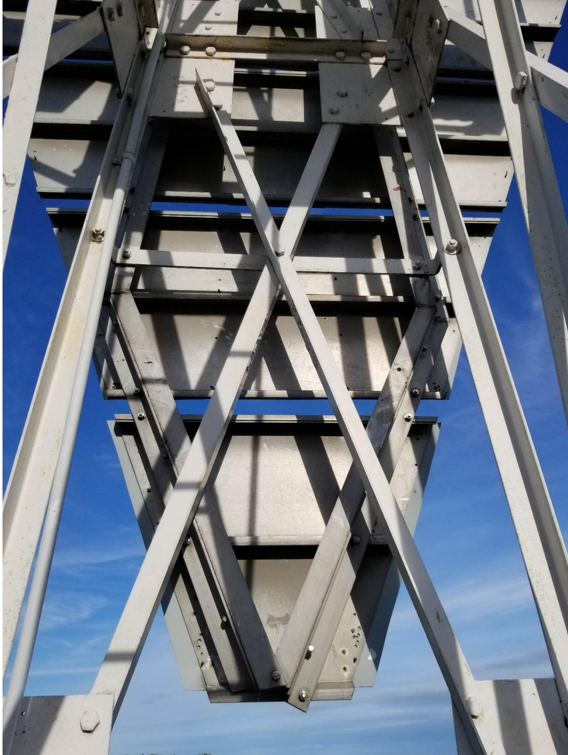
Figure 14 : Phare d'alignement postérieur LL488 de Brighton existant – Panneaux de marques de jour
