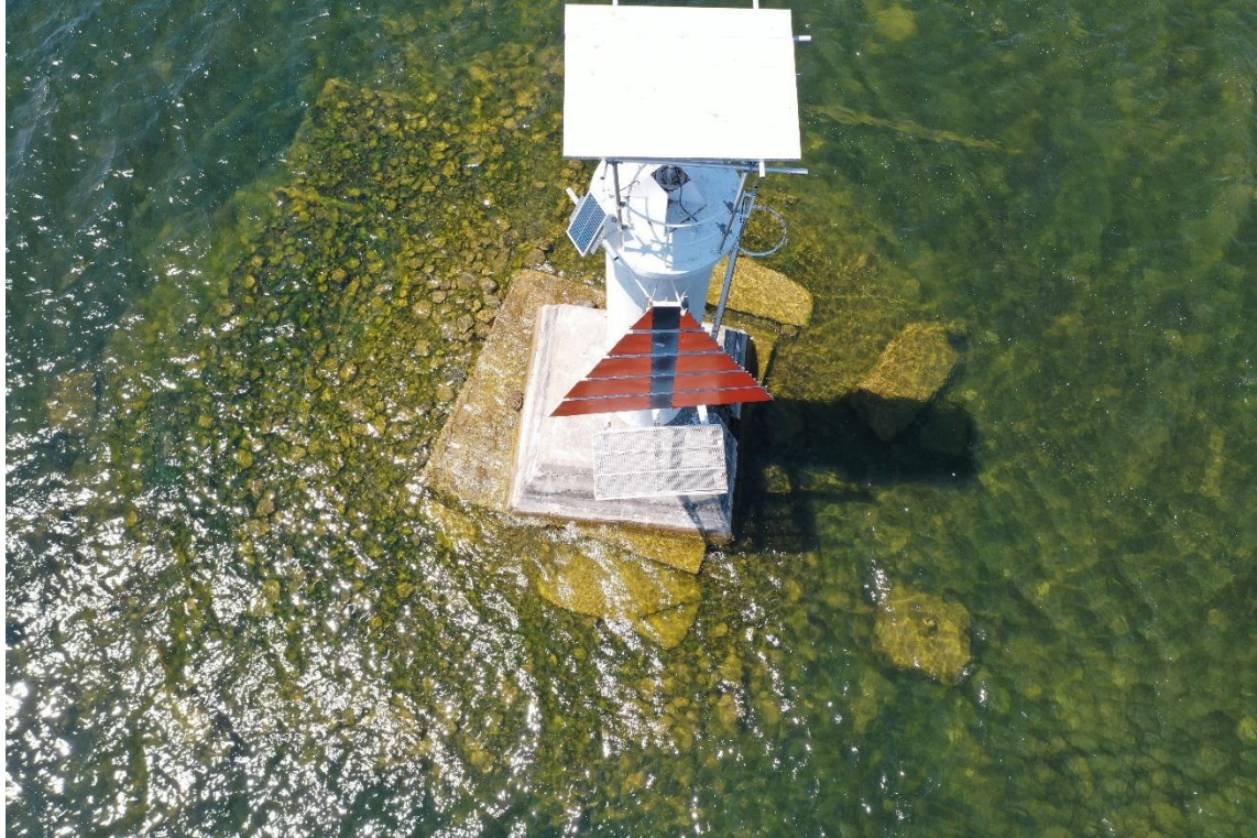
Figure 6 : Phare d'alignement antérieur LL487 de Brighton existant – Vue vers l'ouest, en plongée
