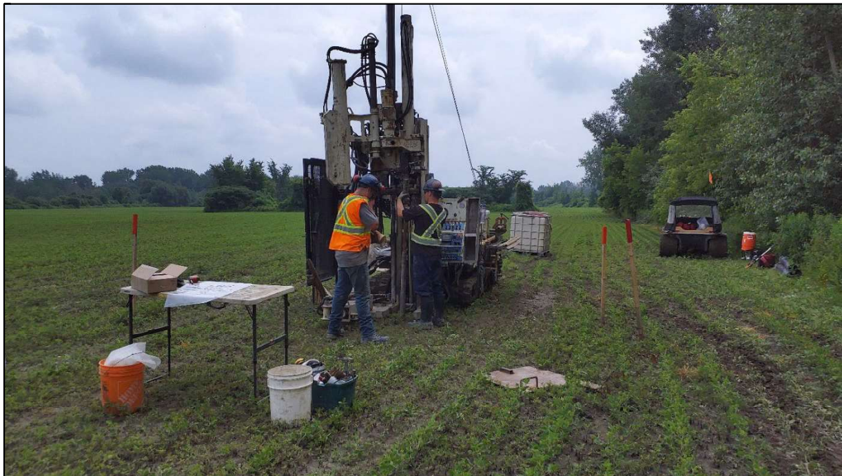
Figure 1 : Emplacement des forages au droit de la nouvelle structure FP (Feu Postérieur)
