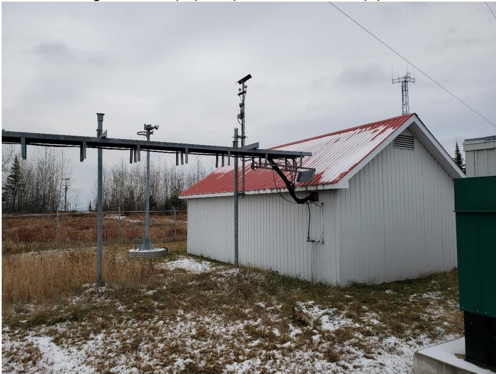
**Figure 4** : Bâtiment actuel avec chemin de câbles et tour de mât tubulaire
