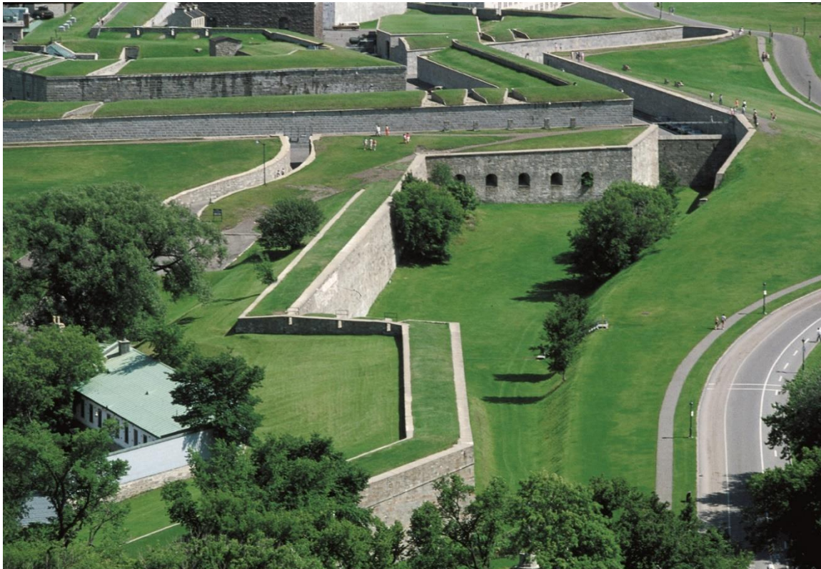
Figure 1 – Vue générale des fortifications
