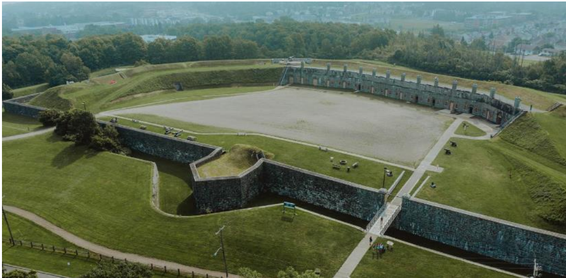
Figure 1 – Vue générale des fort-de-Lévis
