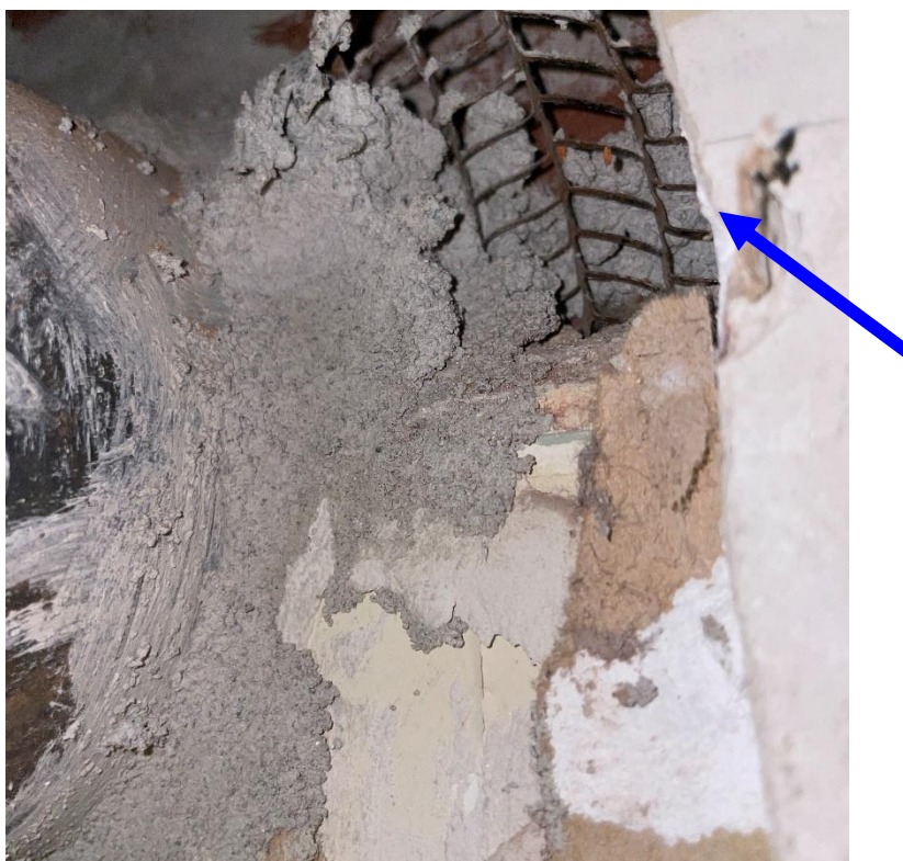
Figure 3: Photographie représentative du plâtre mural (couches blanches et grises) observé derrière les cloisons sèches dans toutes les zones du projet. Il est confirmé que le composé à joints pour cloisons sèches ne contient pas d'amiante (ID de l'échantillon : AS-03A-D).
