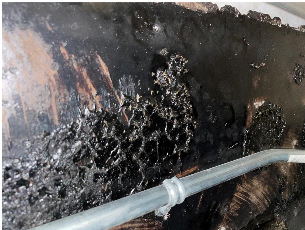
Figure 2: Photographie représentative de goudron noir sans amiante sur un panneau de liège observé dans l'espace du plafond du 2e étage (ID de l'échantillon : AS-02A-C).
