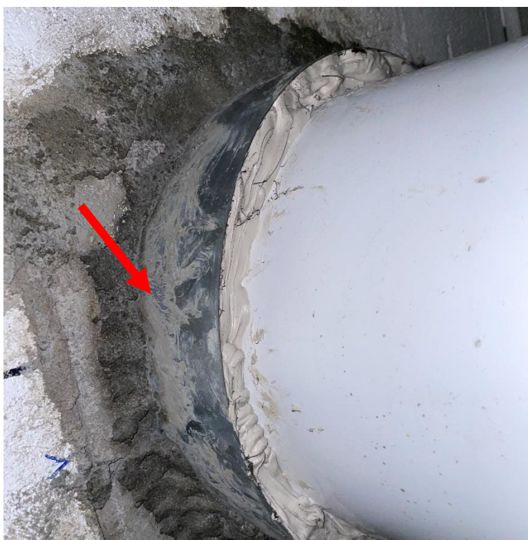
Figure 1: Photographie représentative de crêpe de ciment sans amiante au niveau des pénétrations de tuyaux dans la salle mécanique du rez-de-chaussée (salle 1457). Il est confirmé que le crêpe de ciment ne contient pas d'amiante (ID de l'échantillon : AS-01A-C).
