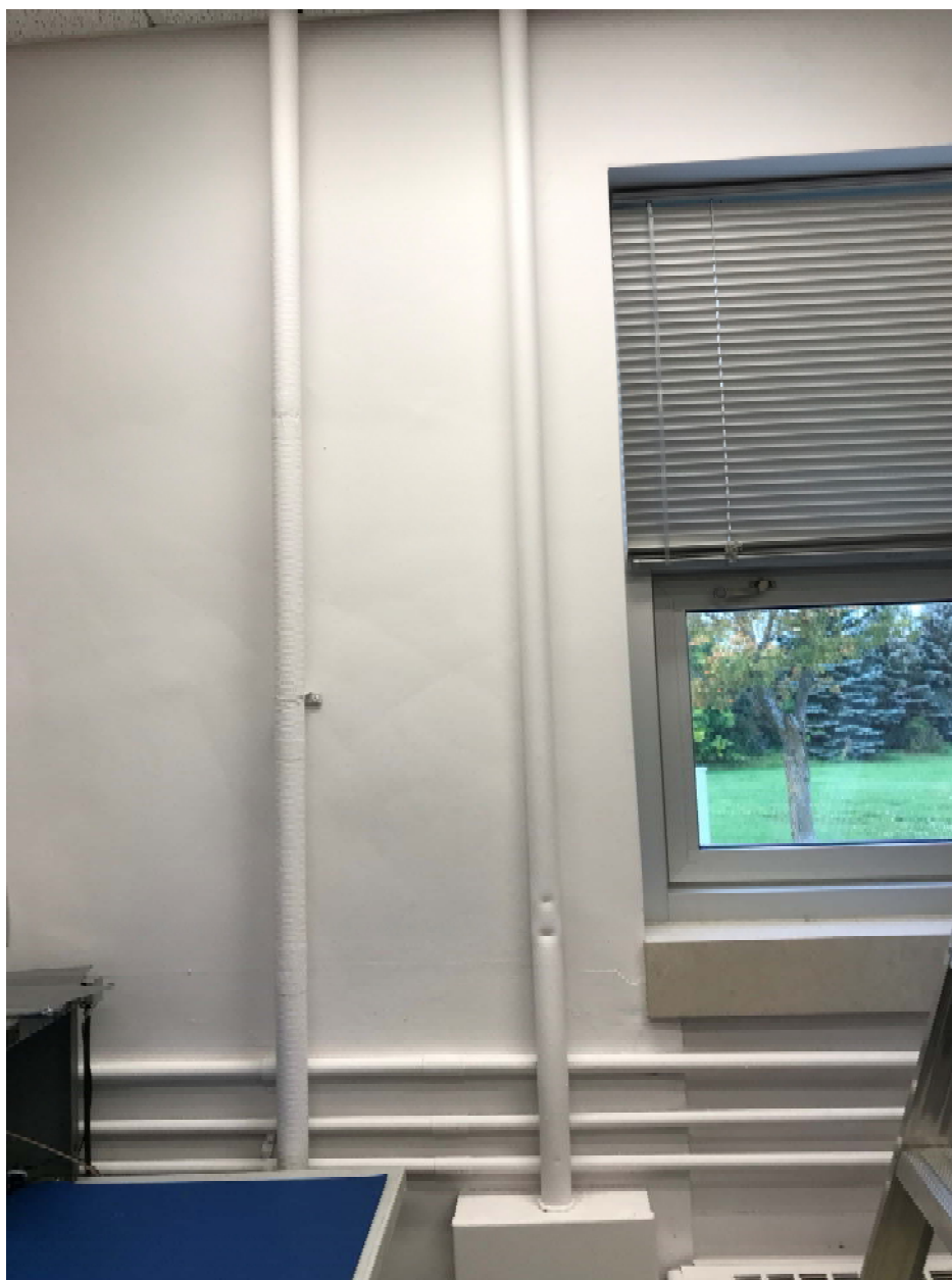
Photo 5 : la peinture blanche observée dans les bureaux du fond contient 388 ppm de plomb (échantillon Englobe LP01).
