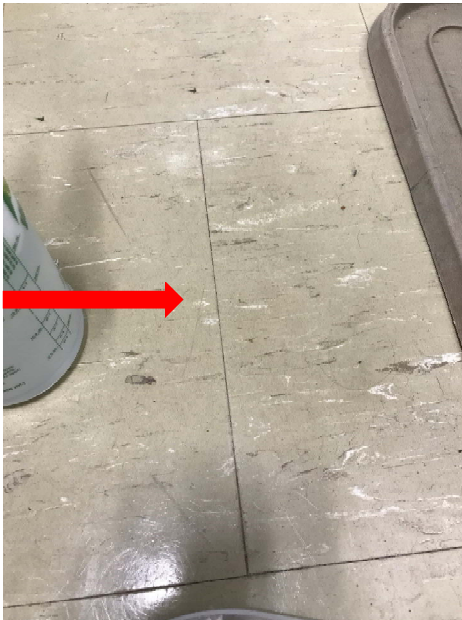
Photo 1 : tuiles de vinyle 12" x 12" brun clair tacheté de blanc présentes dans toute la zone du projet. Contiennent 3 % d'amiante de type chrysotile (échantillon Englobe 9698-01).
