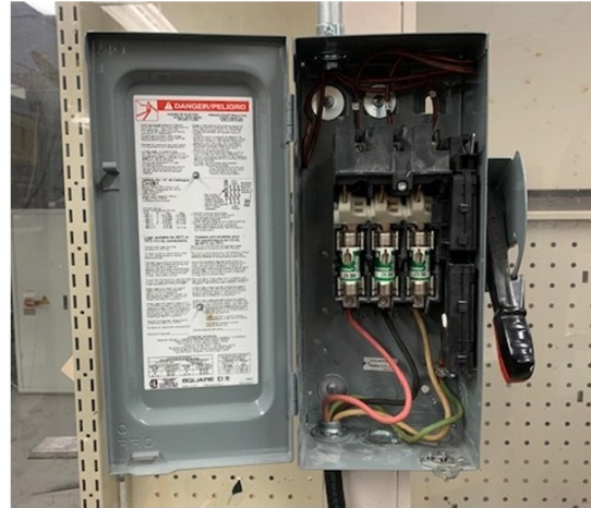
bloc d'alimentation de 575 V en c.a. / 3 phases / 60 Hz, 30 A
