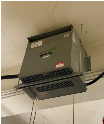
Figure 3-4 Exemples de transformateurs suspendus au plafond de l'atelier
