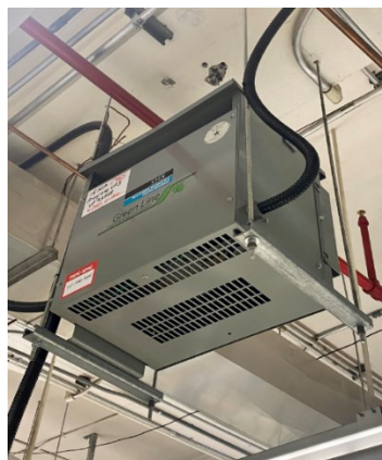
Figure 3-4 Exemples de transformateurs suspendus au plafond de l'atelier
