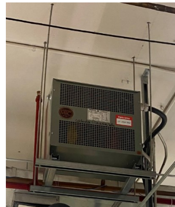
Figure 3-4 Exemples de transformateurs suspendus au plafond de l'atelier
