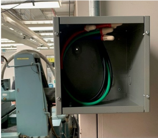
bloc d'alimentation de 208 V en c.a. / 3 phases / 60 Hz, 70 A
