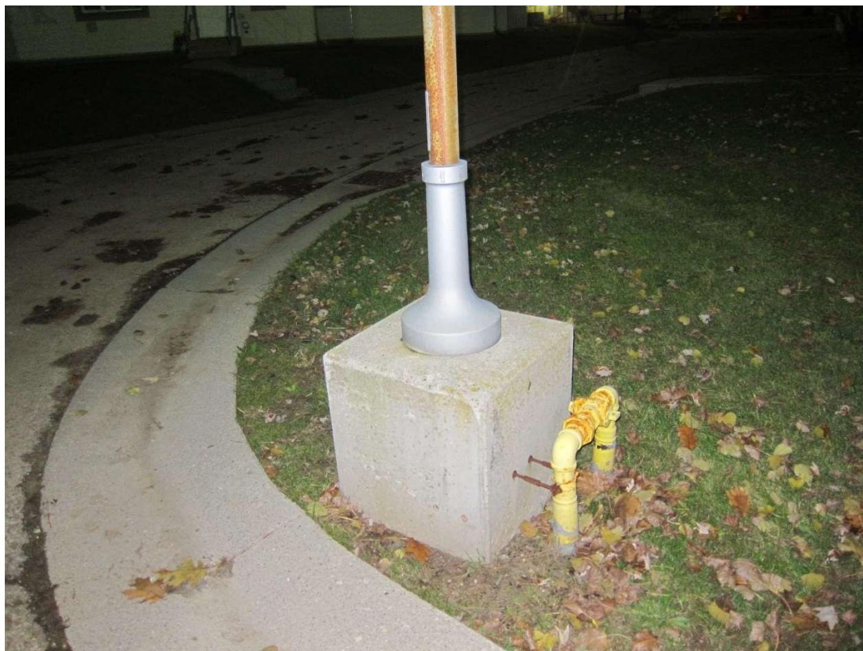
Base du poteau existant à la vanne de gaz naturel
