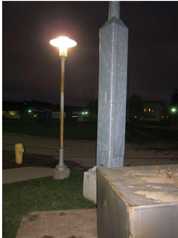
Poteau d'éclairage extérieur type existant et luminaire
