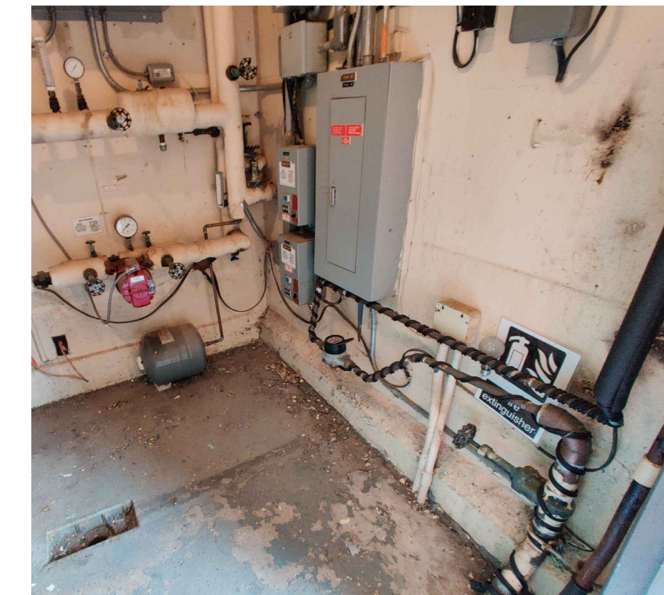
ÉTAT DU SITE EXISTANT : BÂTIMENT 138
