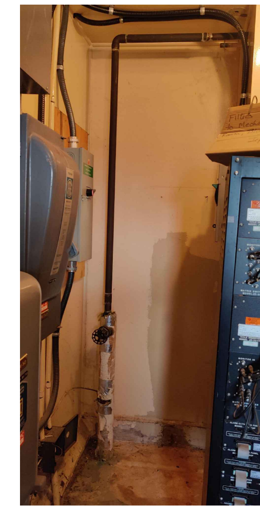
ÉTAT DU SITE EXISTANT : BÂTIMENT 130
