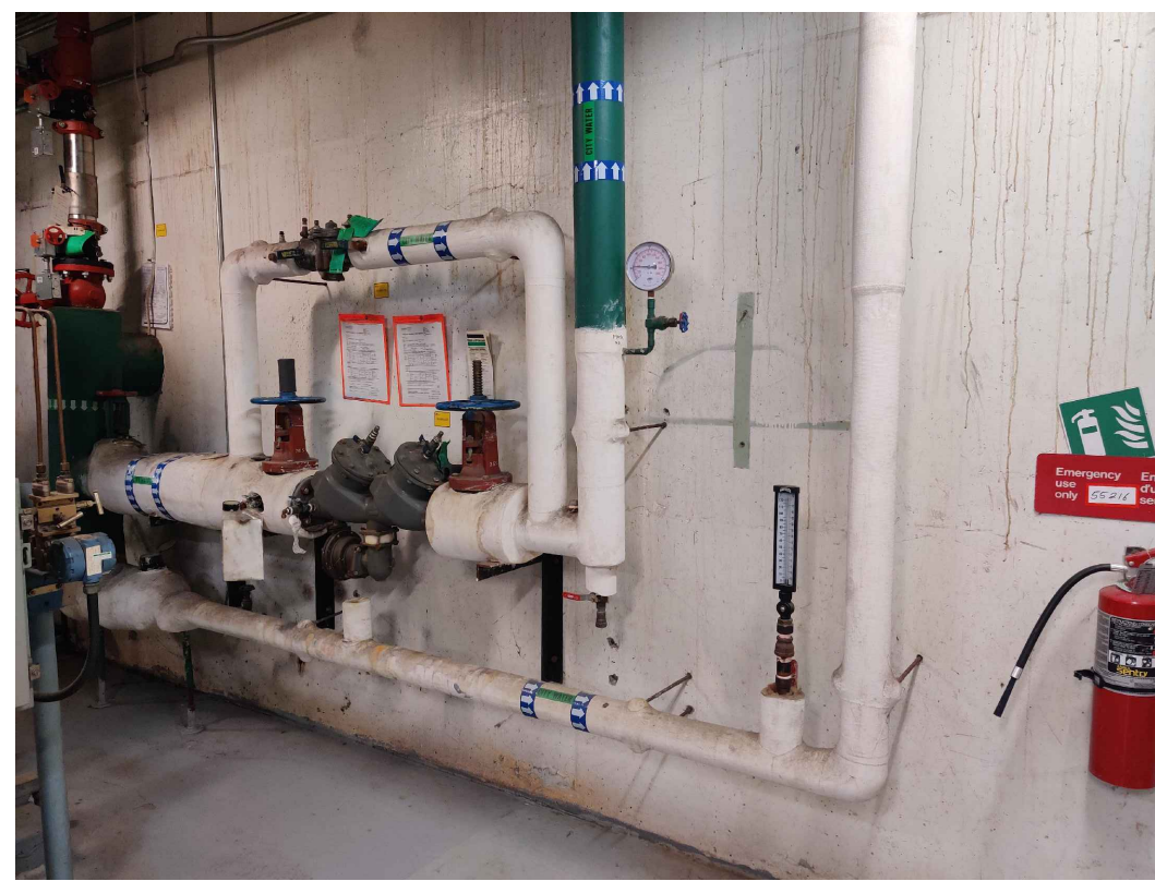
ÉTAT DU SITE EXISTANT: CENTRALE THERMIQUE
