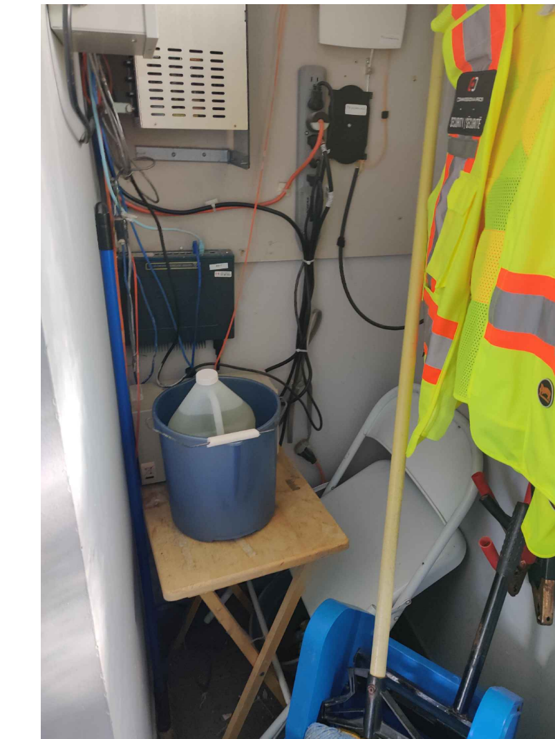
ÉTAT DU SITE EXISTANT: POSTE DE GARDE
