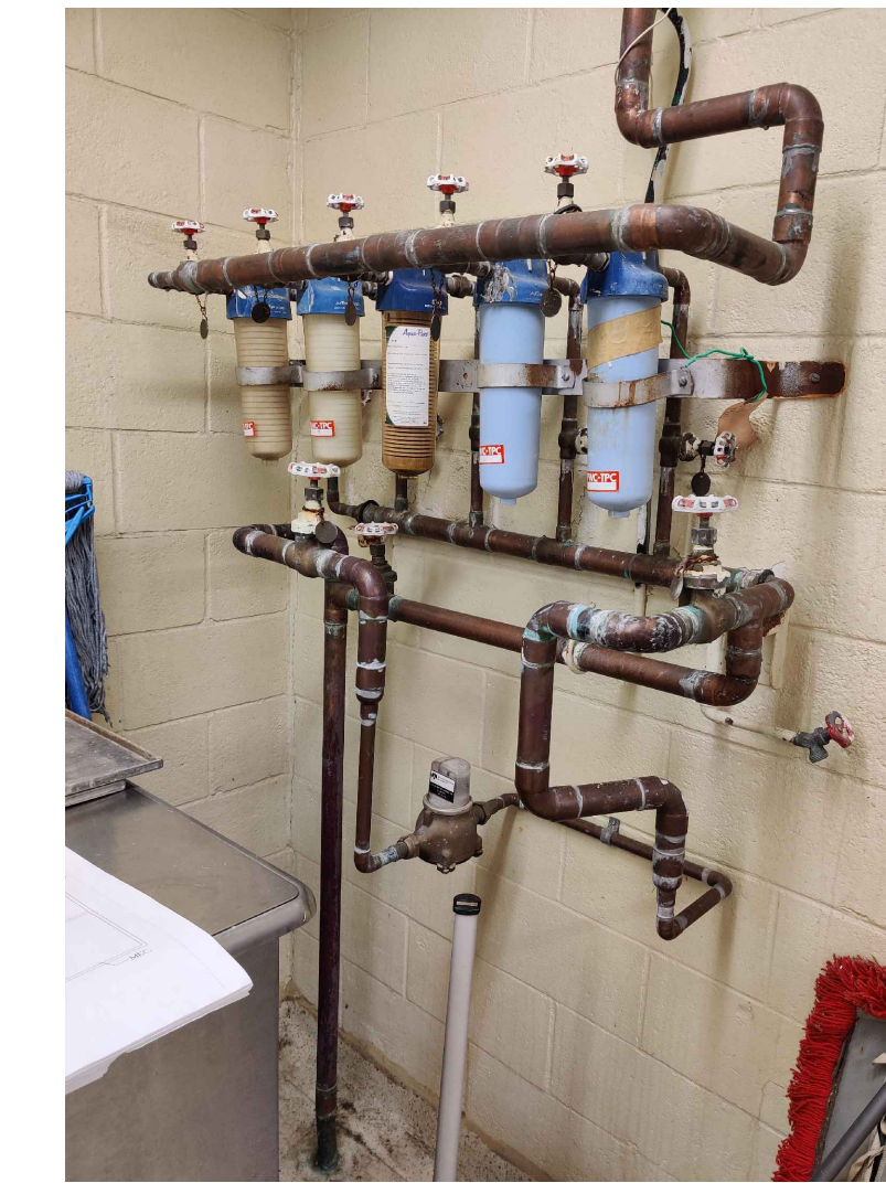
ÉTAT DU SITE EXISTANT: BÂTIMENT 210
