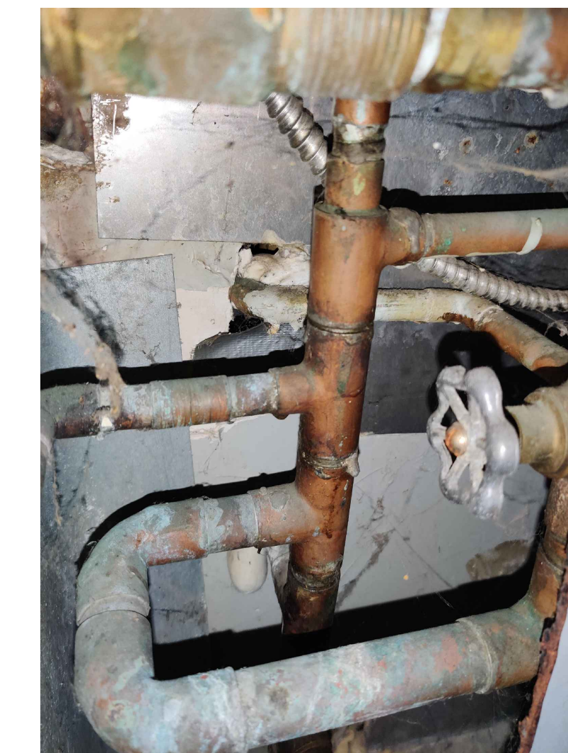
ÉTAT DU SITE EXISTANT: POSTE DE GARDE
