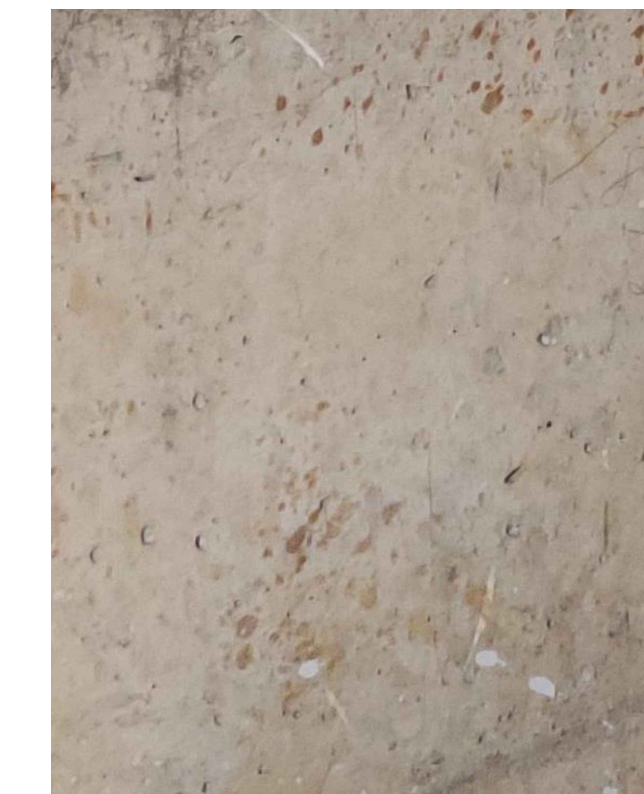
ÉTAT DU SITE EXISTANT: BÂTIMENT 201-A
