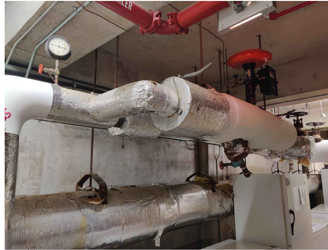
TYP A M-12 ÉTAT DU SITE EXISTANT: BÂTIMENT 201-B
