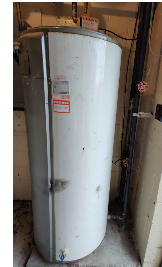
ÉTAT DU SITE EXISTANT: BÂTIMENT 169
