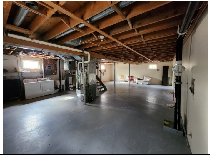
Basement viewed from NE corner showing north wall & Radon system. - Sous-sol vu du coin NE montrant le mur nord et le système de radon.
