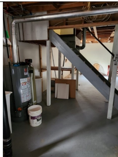
Basement Stairs viewed from east side - Escaliers vus du côté est
